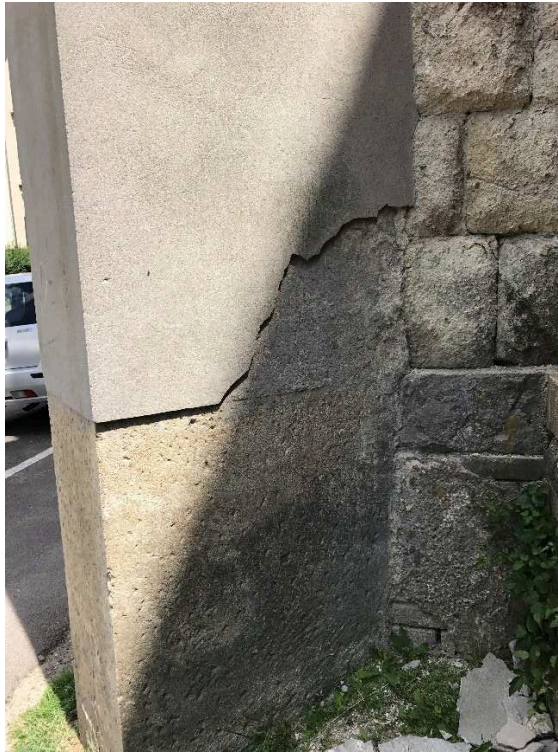
11. kép: kőporos vakolatot fedő cementes vakolat
