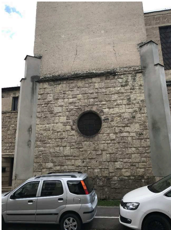
12. kép: kőporos vakolatot fedő cementes vakolat
