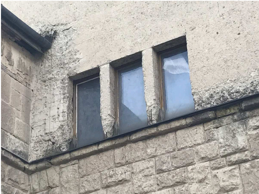
8. kép: sérült csatorna miatt, lefagyott kőporos vakolat
