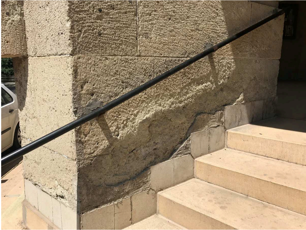
15. kép: lépcső melletti pusztult falsáv
