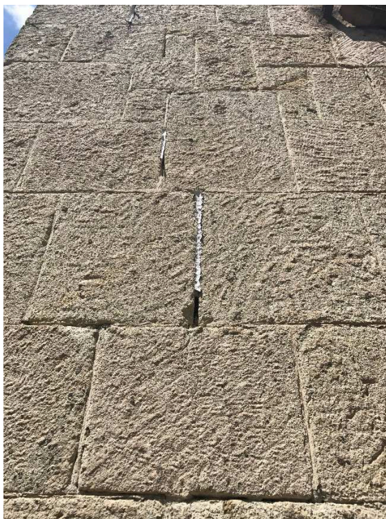
13. kép: a kipergett fugák szakszerűtlen pótlása
