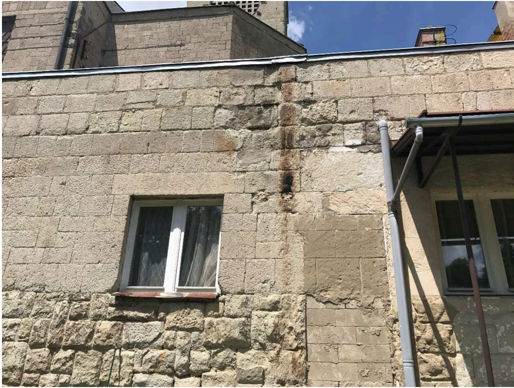
7. kép: sérült bádoglemez fedés miatti ázás
