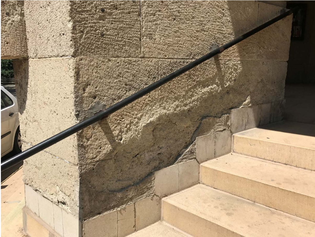
15. kép: lépcső melletti pusztult falsáv
