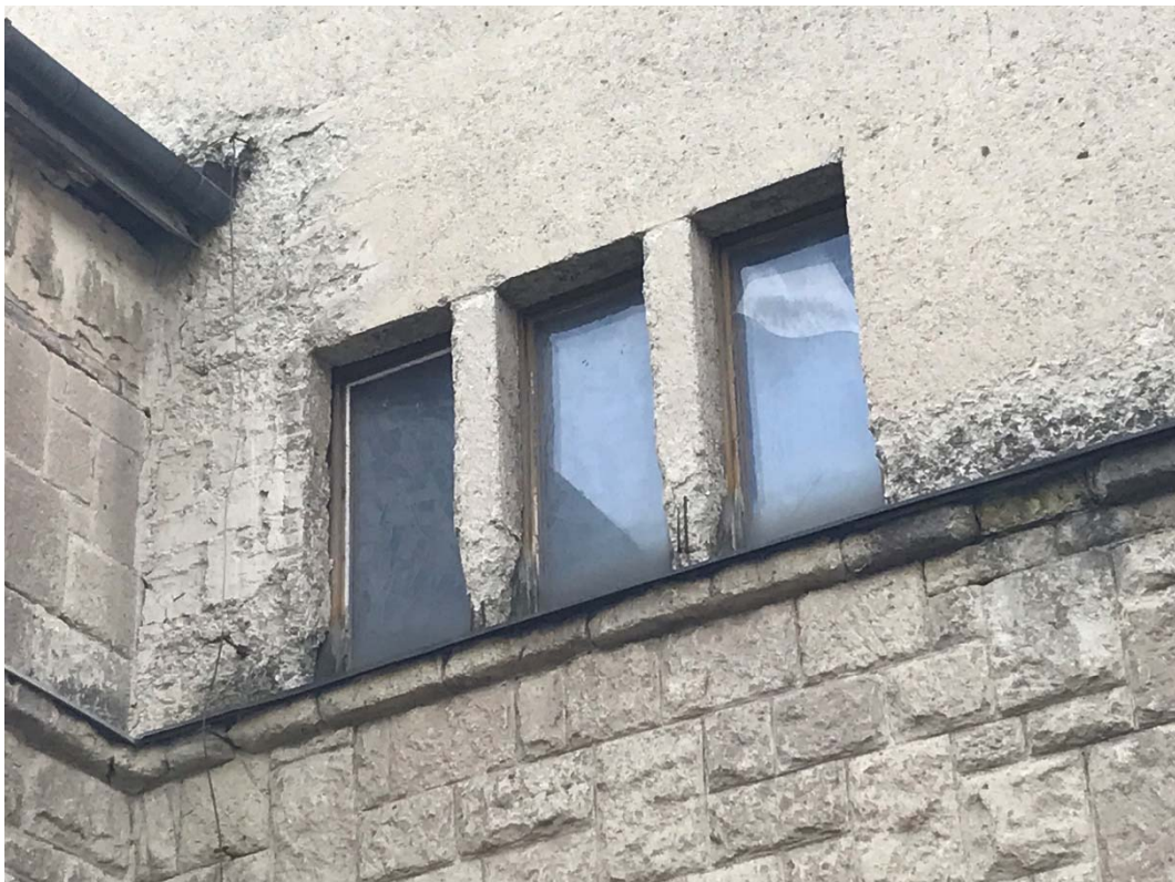
8. kép: sérült csatorna miatt, lefagyott kőporos vakolat
