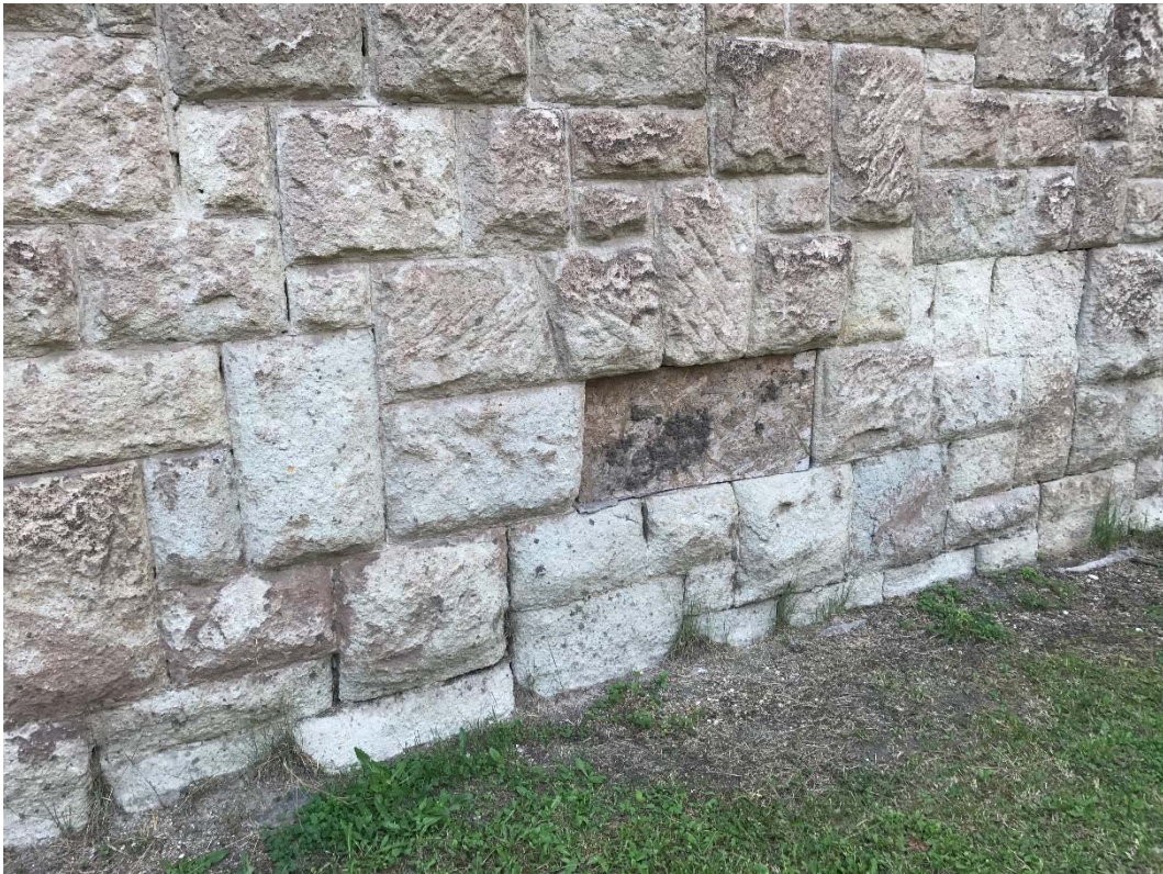
10. kép: a pusztult ciklop falazat
