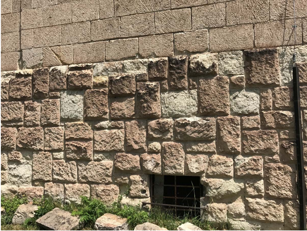
9. kép: a pusztult ciklop falazat
