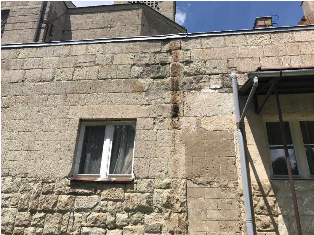
7. kép: sérült bádoglemez fedés miatti ázás
