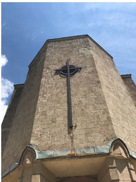
14. kép: a kipergett fugák szakszerűtlen pótlása
